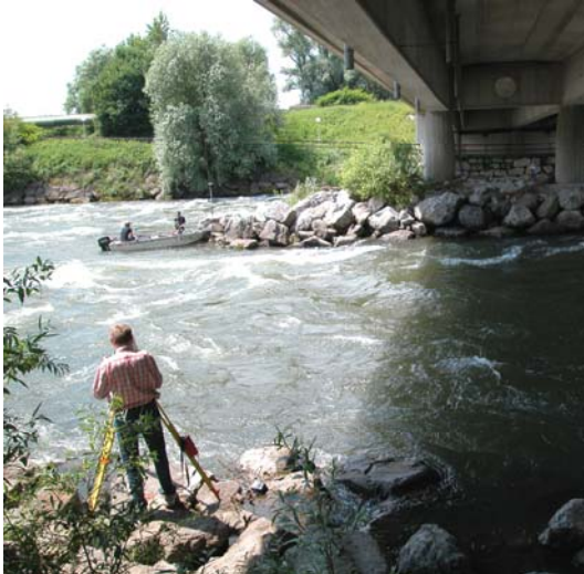
Abb.1: Blockwurf im Schwallstreckenbereich der Mur in Graz
